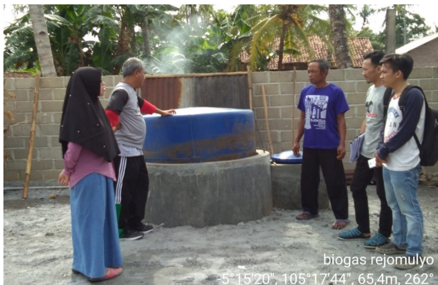
Gambar 4. Digester biogas tipe floating drum kerjasama Tim Penulis dengan Gapoktan Sido Rukun, Desa Rejomulyo, Lampung Selatan (Foto: Agus Haryanto, 2018)
