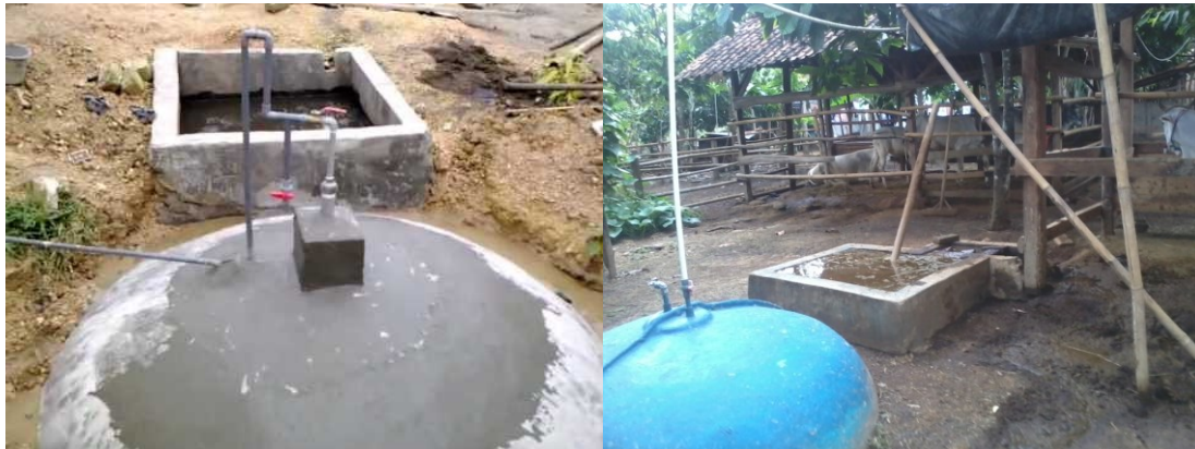
Gambar 2. Digester biogas tipe fixed-dome yang disebarluaskan melalui Program BIRU (kiri) dan tipe fixed-dome dari bahan fiber glass (Haryanto, 2012)
